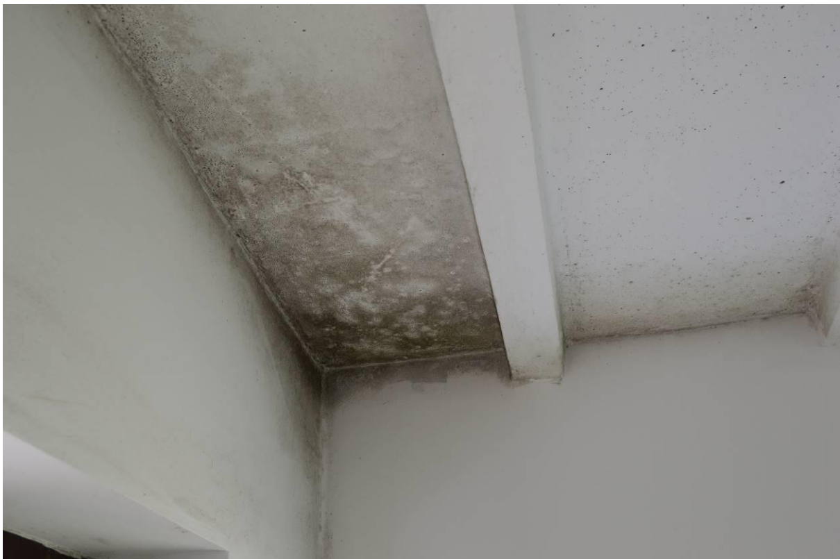
Fot. 4 – Zagrzybienie stropodachu wiatrołapu
