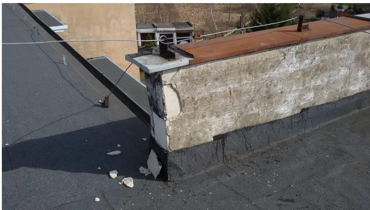
Fot. 5 – Odpadający tynk z attyki
