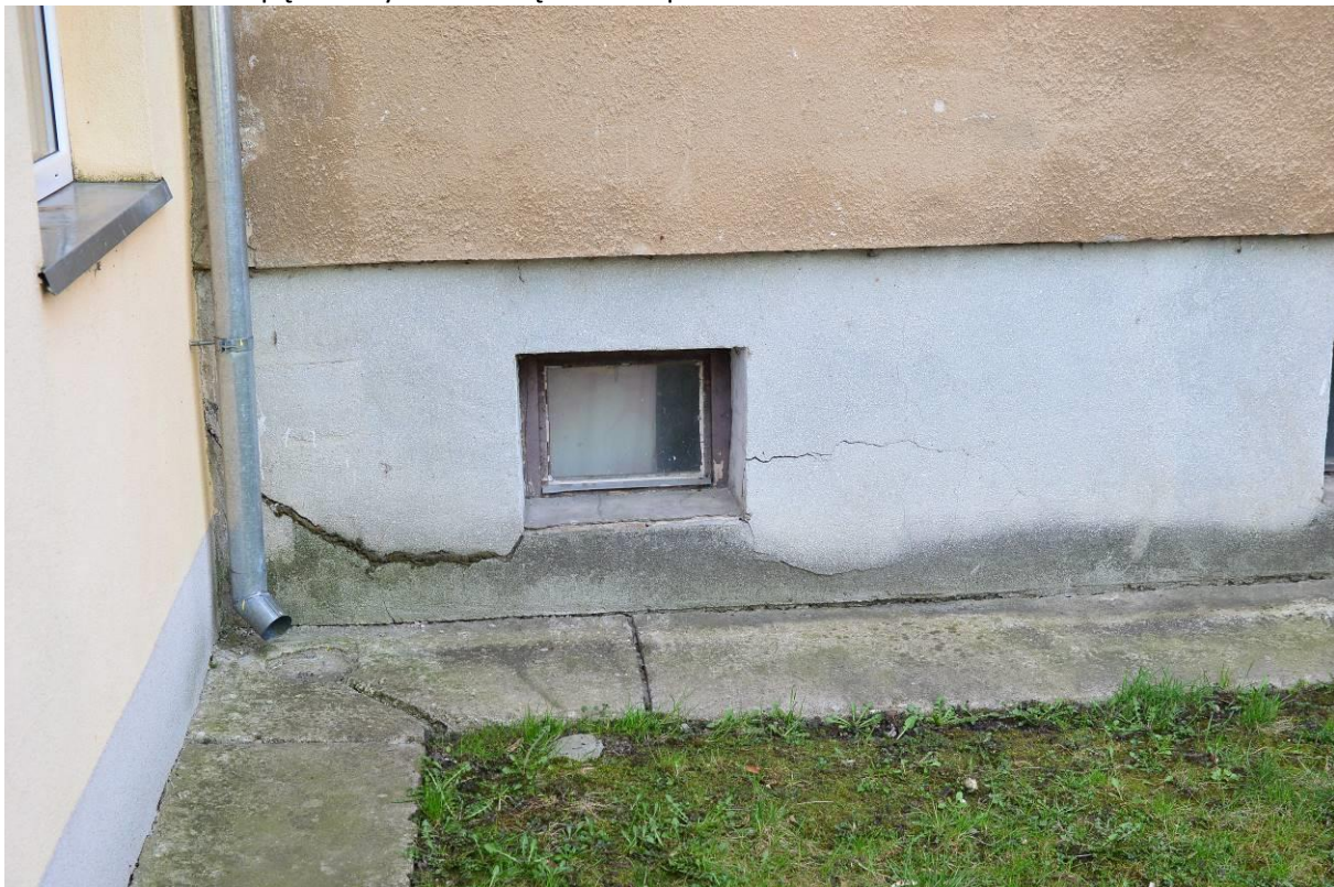
Fot. 3 – Widoczne spękania tynku w obrębie ścian piwnic
