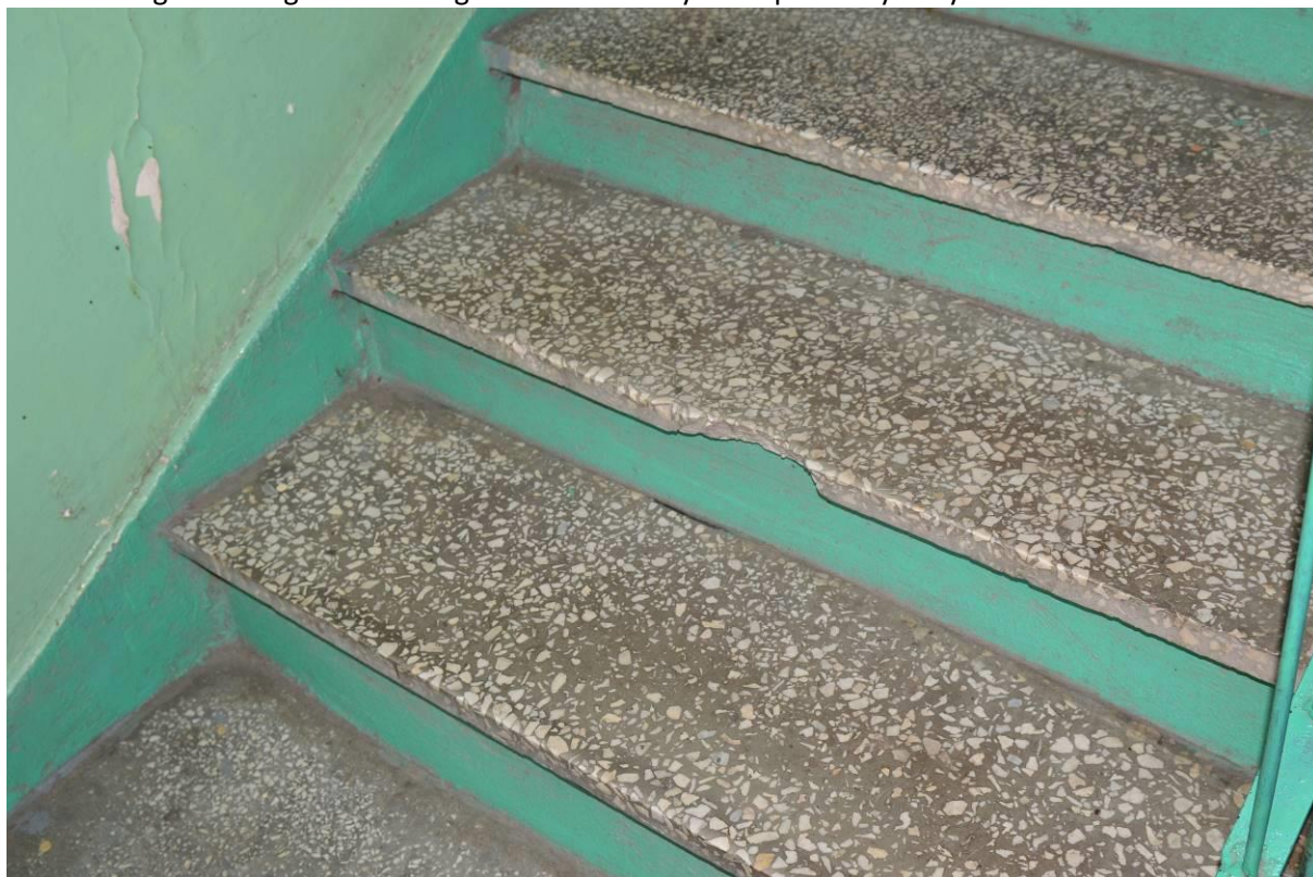
Fot. 2 – Fragment biegu schodowego – widoczne ubytki stopni lastrykowych
